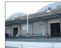
岡山商品センター 延床面積：488.00坪
