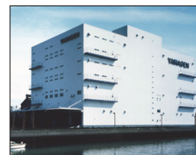
船橋商品センター 開設年月：平成7年4月 延床面積：2,552.72坪 敷地面積：1,282.13坪
